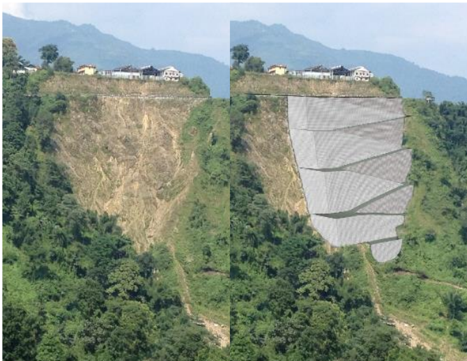
Initial situation (landslide)
